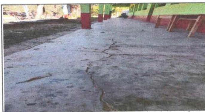
Foto 6: Se observa el deterioro del piso del de corredor y las tres aulas y dirección de la escuela.
