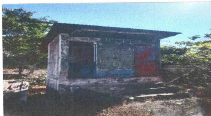
Foto 4: se observa desprendimiento de pintura de la pared de la letrina.
