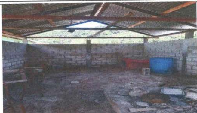
Foto 1. Colocación de piso concreto de la cocina.
